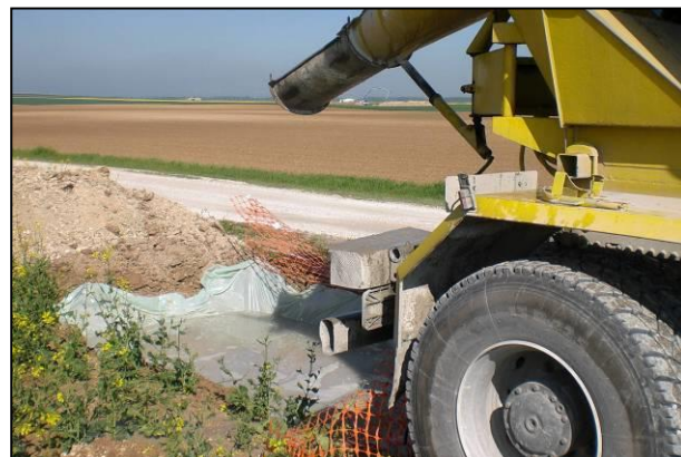
Photo 130 : Exemple de récupération des laitances de béton (Source : BE Jacquel et Chatillon)
